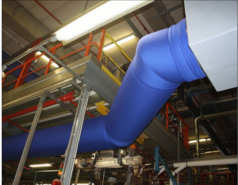
Voor een optimale spotkoeling werden de luchtkanalen zeer precies gepositioneerd
