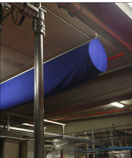
Kanaal in opbouw
